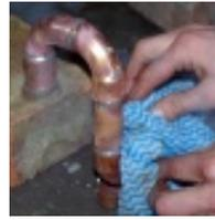
Metallfließ reinigen, alle zu lötenden Teile mit Flußmittel einschmieren, zusammenstecken und überlegen in welcher Reihenfolge gelötet werden muss. Löten und anschließend gut spülen, damit keine Rückstände vom Flussmittel im Rohr verbleiben.
