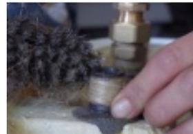
Arbeitsschritte mit Teflon: vom Gewindeanfang in Schraubrichtung drumwickeln, Gewinde zusammenschrauben.
