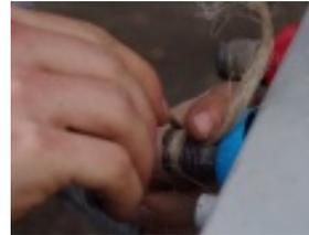
Arbeitsschritte mit Hanf: Gewinde mit (altem) Sägeblatt anrauen. Anschließend ein der Gewindegröße entsprechendes Faserbündel Hanf nehmen und dieses vom Gewindeanfang in Schraubrichtung fest um das Gewinde wickeln. Das gewickelte Hanf sollte fest im Gewinde sitzen und sich nicht lose drehen lassen. Danach mit einer Drahtbürste den Hanf ins Gewinde bürsten (ebenfalls in Schraubrichtung). Zum Schluss Neofermit darüber streichen und Gewinde ggf. im Schraubstock zusammenschrauben.
